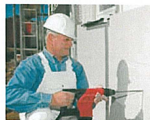
Befestigung der Dämmplatten
