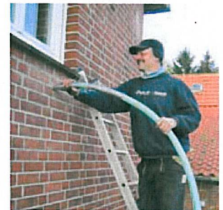
Hohlräume werden verfüllt
